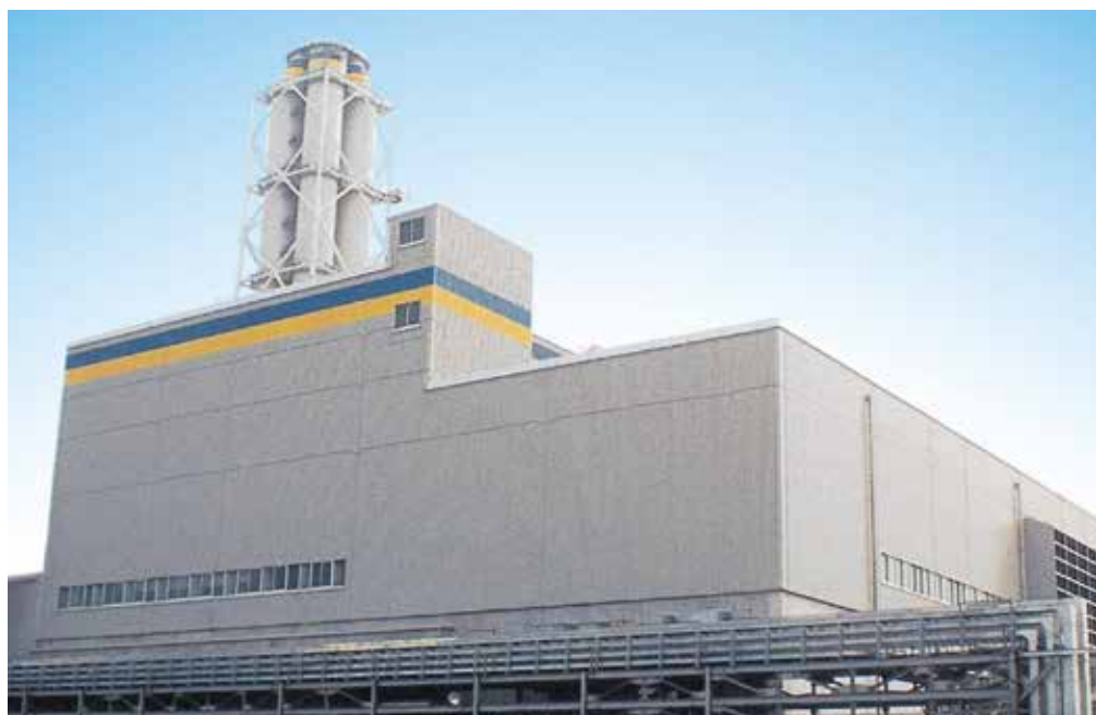
中部電力(株)上越火力発電所本館
