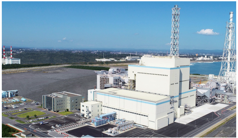
常陸那珂火力発電所
