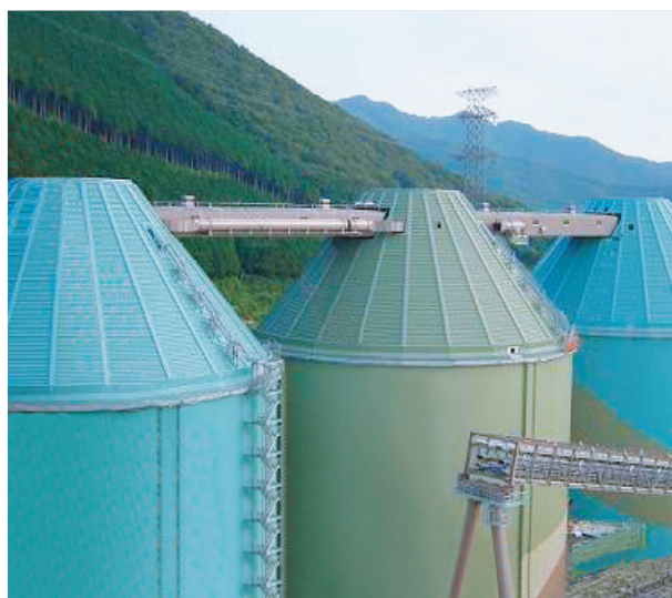
関西電力(株)舞鶴火力発電所サイロ
